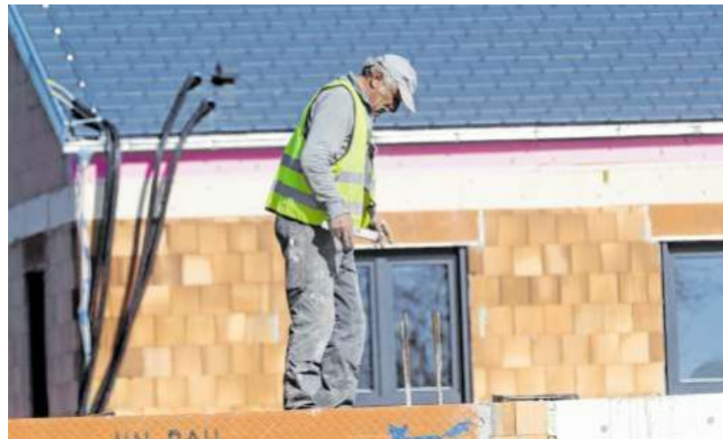
Die Vorschriften am Bau machen Bauherren und Firmen zu schaffen.
