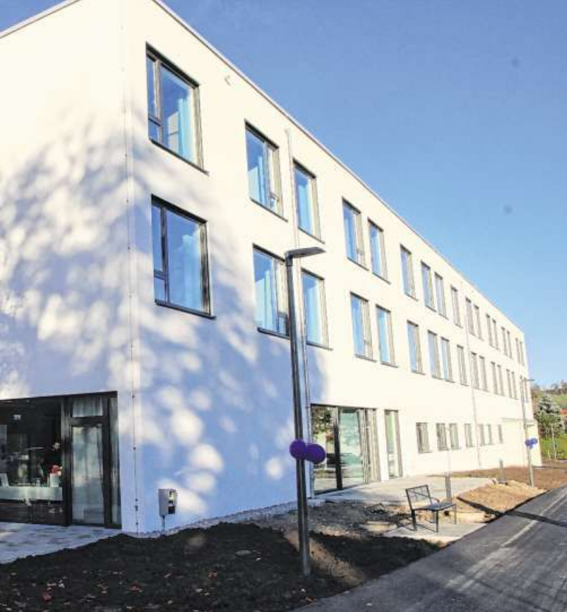
Im Erdgeschoss des Neubaus befindet sich die Notaufnahme, im ersten und zweiten Stock die Bettenstation der Chirurgie. Fotos: Matthias Matz
