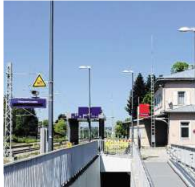
Der Bahnhof in Türkheim ist seit dem Umbau einer der modernsten in der Region. Foto: Sabine Schaa-Schilbach
