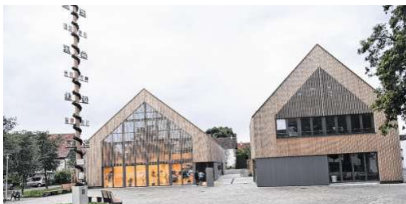
Der Legauer Marktplatz hat sich durch den neuen Festsaal und die Löwen-Gastronomie deutlich verändert. Der Baustoff Holz soll für eine Verbindung von Tradition und Moderne sorgen. Foto: Armin Schmid
