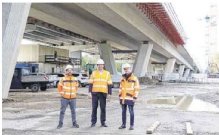
Baustellenbegehung in Memmingen (von links): Martin Imhof (Abteilungsleiter im Brückenbau bei der Autobahn GmbH), Stephan Stracke und Tobias Ehrmann. Foto: Abgeordnetenbüro
