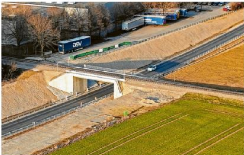
Die neue Bahnübergangsführung an der Staatsstraße 2518 – in der Region besser bekannt als alte B18 – beim Skyline Park geht ihrer Vollendung entgegen. Da noch einige Arbeiten nötig sind, muss die Straße aber erneut komplett gesperrt werden.
