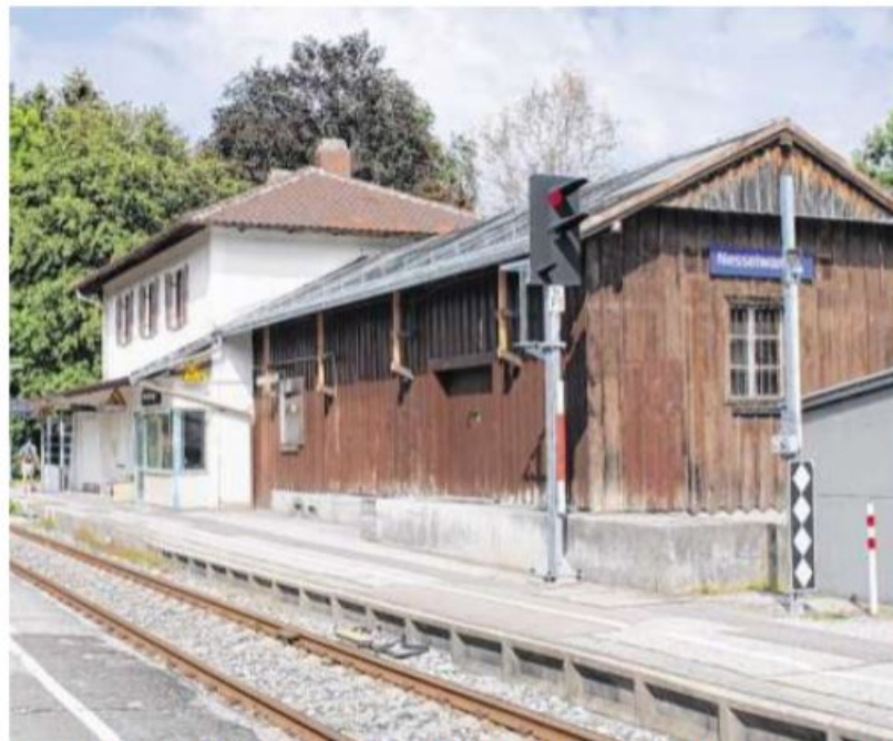
Kein Aushängeschild für den Markt Nesselwang sind der Bahnhof und sein Umfeld in seinem jetzigen Zustand. Nun werden erst die Bahnsteige barrierefrei umgestaltet, danach werden Bahnhof und Umfeld attraktiver gemacht. Foto: Markus Röck (Archiv)
