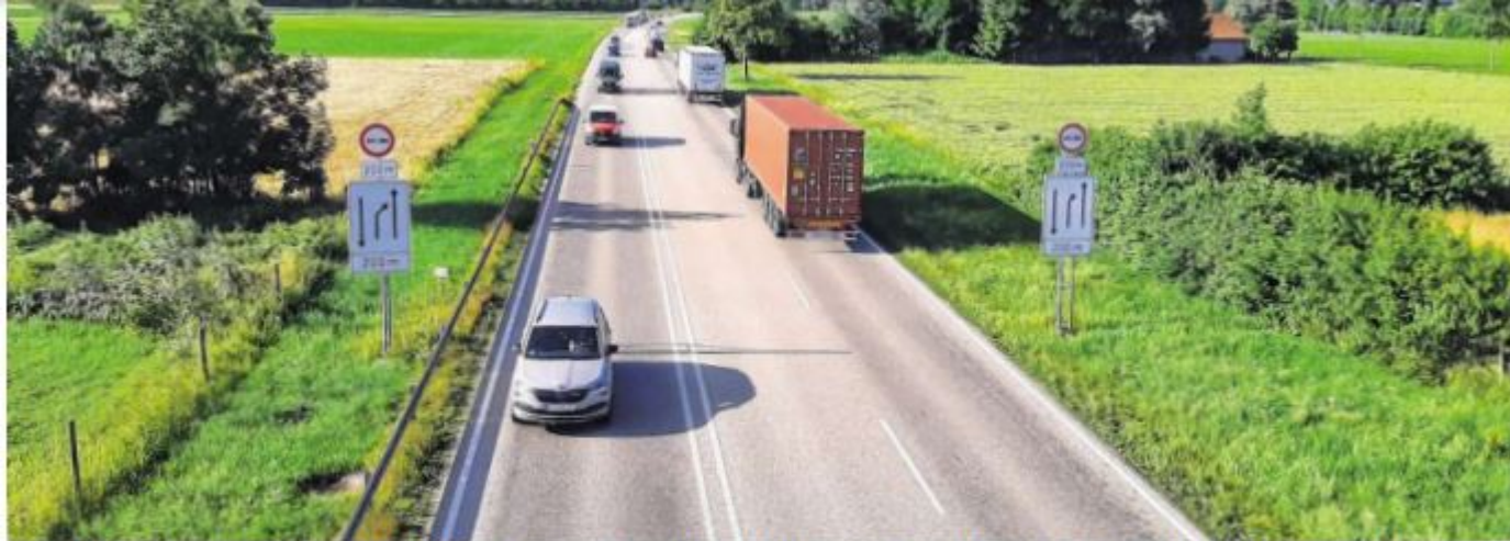
Auf dem 10,2 Kilometer langen nördlichen Bereich der B 12 zwischen Buchloe und Germaringen liegt zurzeit der Fokus beim Ausbau der Bundesstraße. Das Foto wurde von der Waldstraßenbrücke bei Lindenberg in Richtung Süden aufgenommen.
