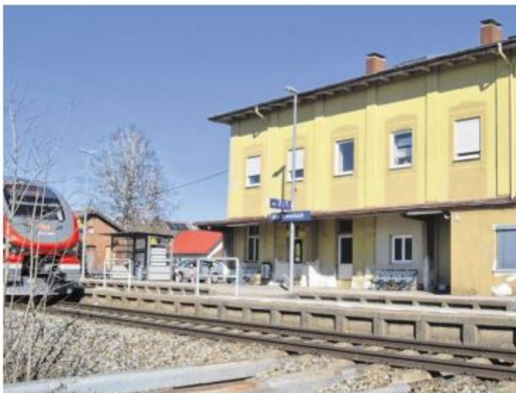
Der Bahnhof in Bad Grönenbach ist in das Förderprogramm „1000 Bahnhöfe“ des Bundesverkehrsministeriums aufgenommen worden und soll barrierefrei werden. Die Bauarbeiten sollen Anfang 2024 erfolgen.
