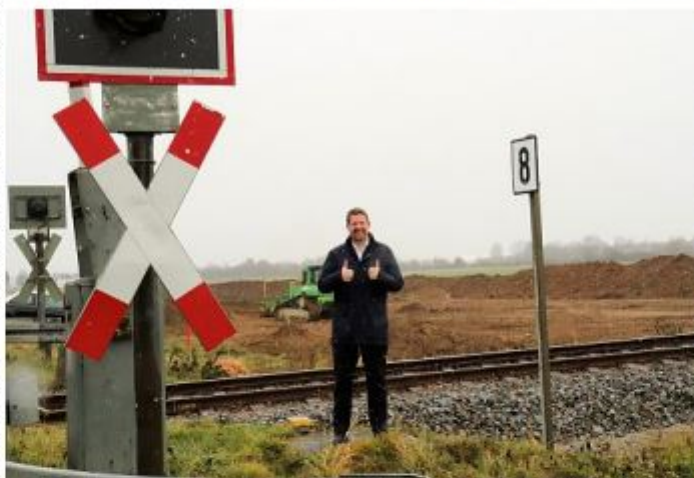
Der Allgäuer Bundestagsabgeordnete Stephan Stracke am Bahnübergang bei Türkheim, an dem nun endlich die Bauarbeiten zur Höhenfreimachung beginnen können.
