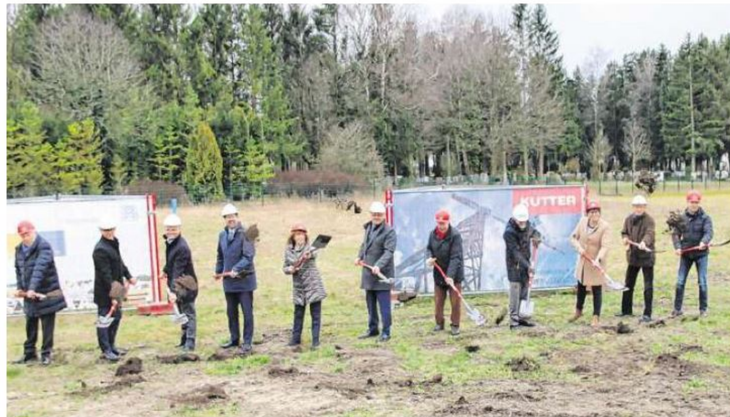
Auf dem Areal an der Lisztstraße, das benachbart zum Waldfriedhof liegt, fand jetzt der symbolische Spatenstich für den Bau von 78 Wohnungen statt. Das Bild zeigt (von links): Rudolf Groll, Geschäftsführer und Inhaber der Baufirma Kutter, Architekt Helmut Schedel, Markus Sonntag, Vorstand der Siebendächer Baugenossenschaft, Bundestagsabgeordneter Stephan Stracke (CSU), Zweite Bürgermeisterin Margareta Böckh (CSU), Oberbürgermeister Manfred Schilder (CSU), Dritter Bürgermeister Dr. Hans-Martin Steiger (SPD) sowie Aufsichtsratsvorsitzenden Josef Dietrich, Claudia Knittel (Vorstand), Aufsichtsratsmitglied Joachim Schanz und Prokurist Robert Schnug von der Siebendächer Baugenossenschaft. Foto: Verena Kaulfersch
