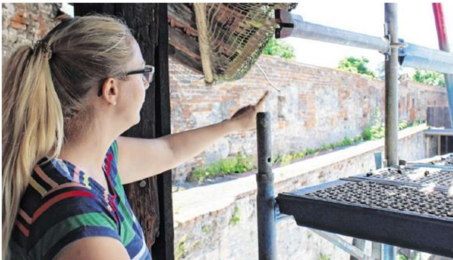
Bauleiterin Viktoria Schuster vom Münchner Ingenieurbüro Barthel & Maus zeigt, was an der Stadtmauer genau gemacht werden muss. Hier ist der Bauabschnitt an der Kohlschanze zu sehen. Auf dem Bild gut zu erkennen: Früher hatte die Mauer Zinnen aus grauem Kalktuff. Sie wurden mit roten Ziegelsteinen ausgemauert. Fotos: Reinwand
