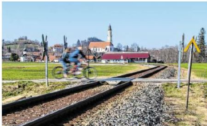
Der Bahnübergang in der Pfrontener Badstraße: Nach mehreren schweren Unfällen wird dort eine Halbschranke gebaut. Foto: Ralf Lienert
