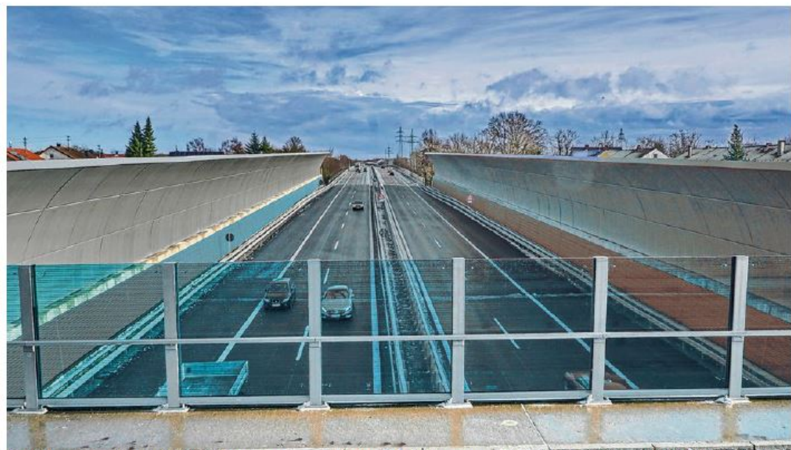
Die Arbeiten sind abgeschlossen, der Verkehr fließt wieder uneingeschränkt: An der A96 bei Amendingen stehen jetzt die neuen, bis zu neun Meter hohen Lärmschutzwände. Die blauen Streifen im unteren Bereich der Wände sind die sogenannten Vorsatzschalen, die Schallwellen absorbieren.
