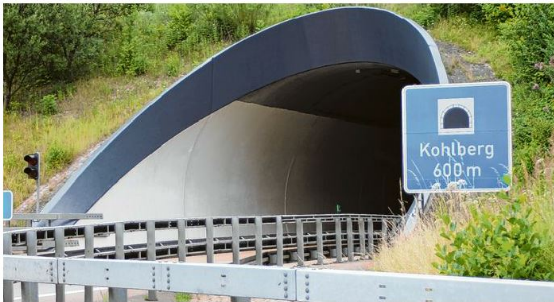
Am Kohlbergtunnel gelten derzeit zwei unterschiedliche Tempolimits. Was es damit auf sich hat, hat jetzt die Autobahndirektion in Kempten erläutert.
